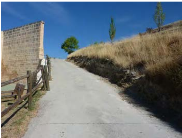
2. Muro norte del frontón y perfil de la carretera (contiene sillares, etc)
