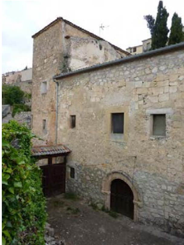
Figura. 1. Lado Sur de lo que sería la nave de la iglesia
