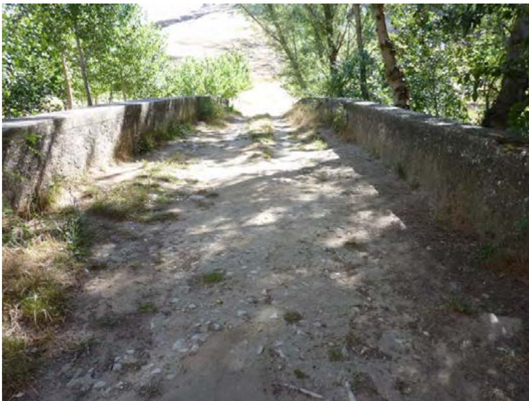
1. Tablero del puente dirección puerta de la Fuerza
