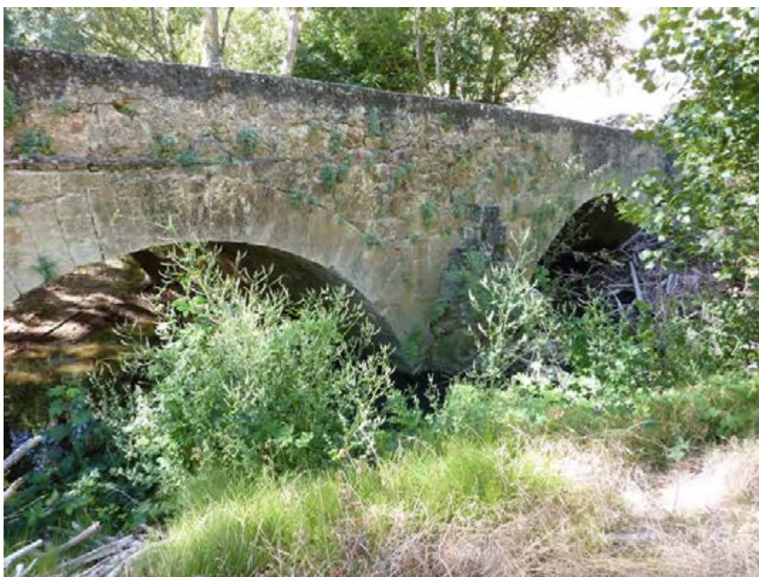
2. Detalle de dos de sus arcos
